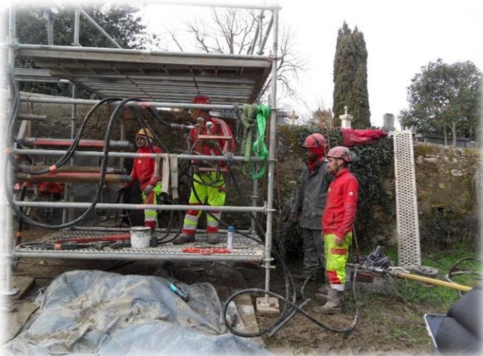
L'ensemble de l'opération de consolidation a été confié à l'entreprise AGTP, basée à Castelnaudary, spécialisée dans les gros travaux sur les ouvrages d'art. L'opération consiste en la mise en place de quatre clous au travers du mur d'une longueur de 12 m, dont 3 m dans la roche du sous-sol. Ils sont stabilisés par l'injection de ciment. Le mur est crépi avec un béton armé projeté d'une épaisseur de 20 cm au total, une croix de saint André termine
